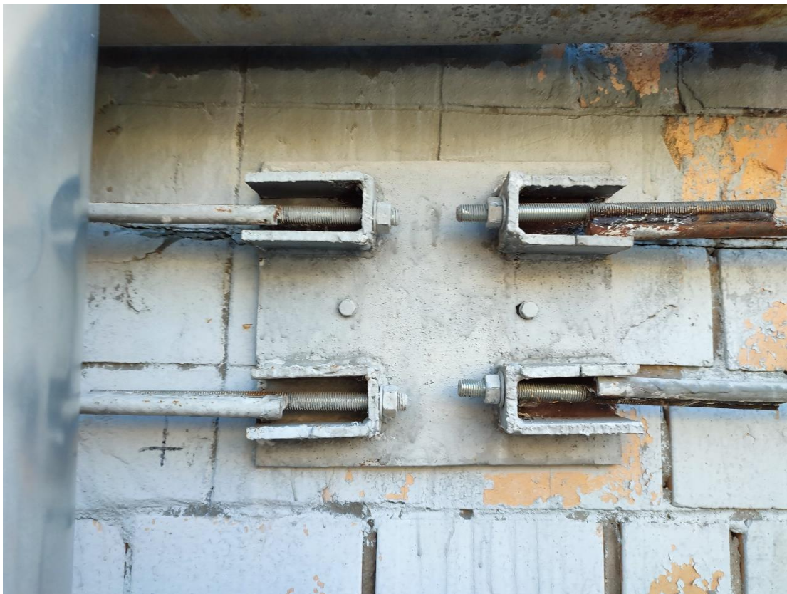
Фото 5.5. Общий вид выполненного узла усиления тяжами
