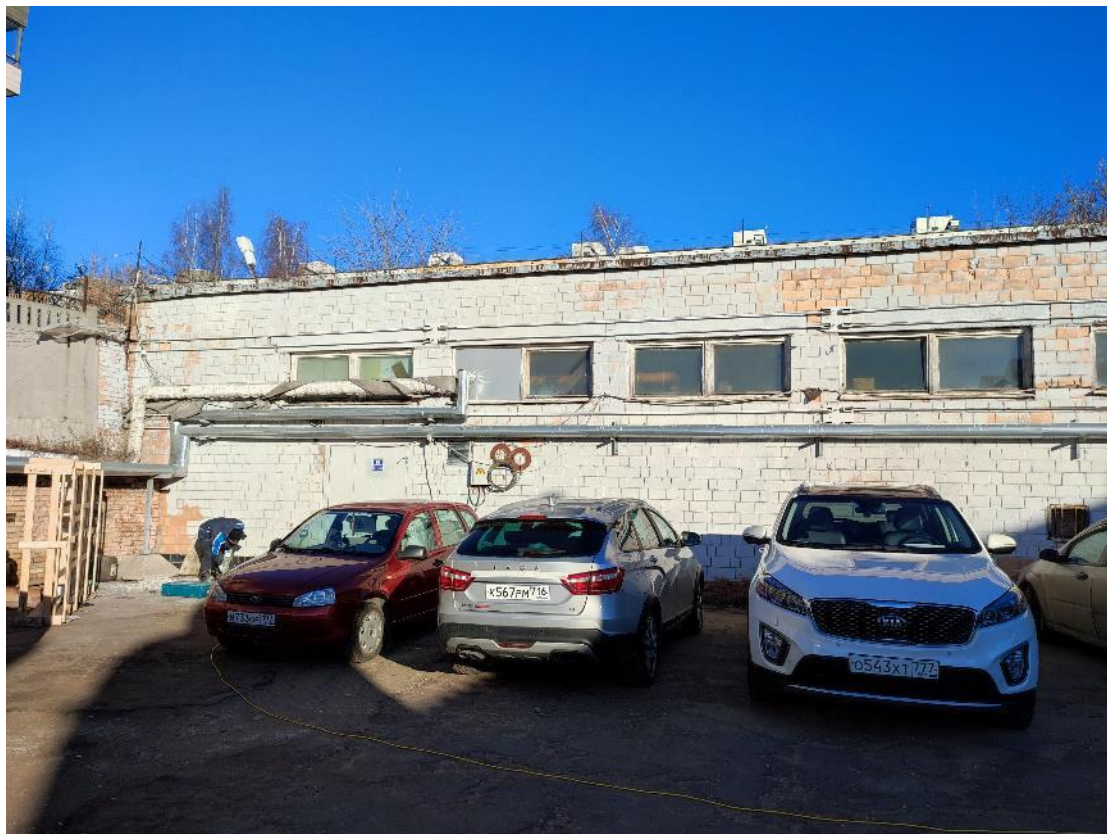
Фото 3.1. Фасад в осях 1-4/А
