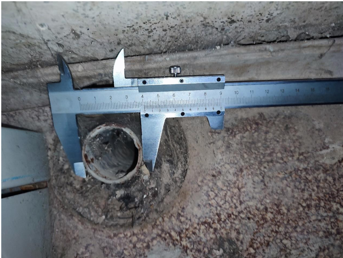
Фото 5.7. Кондуктор для осуществления цементации контактной зоны «фундамент-грунт»
