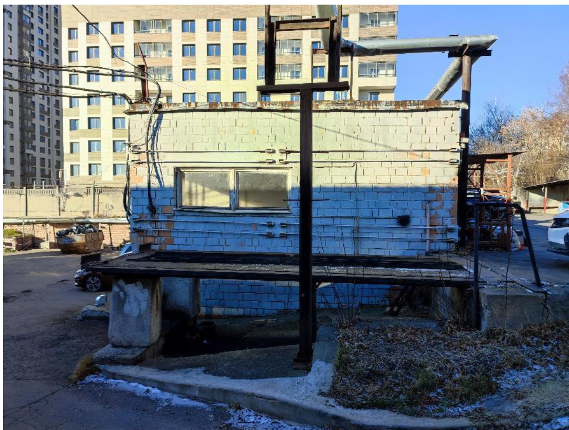
Фото 3.2. Фасад в осях 4/А-Б
