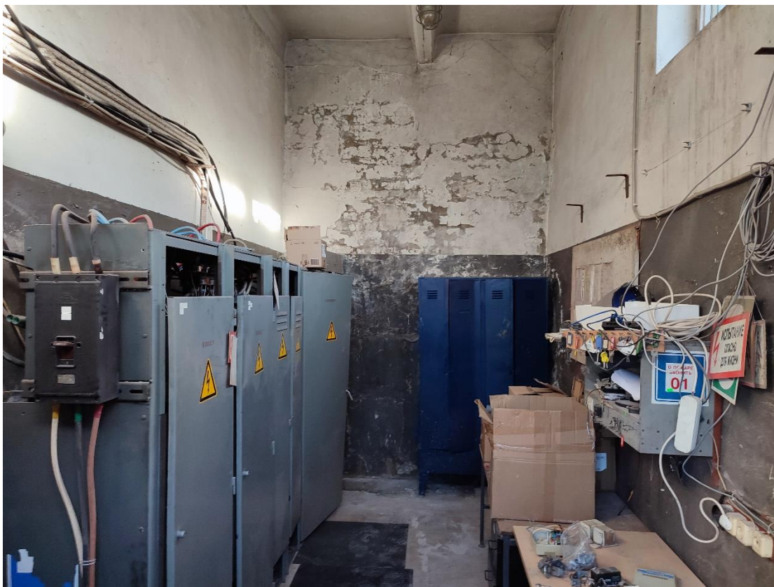
Фото 3.6. Общий вид конструкций здания в осях 3-4/А-Б
