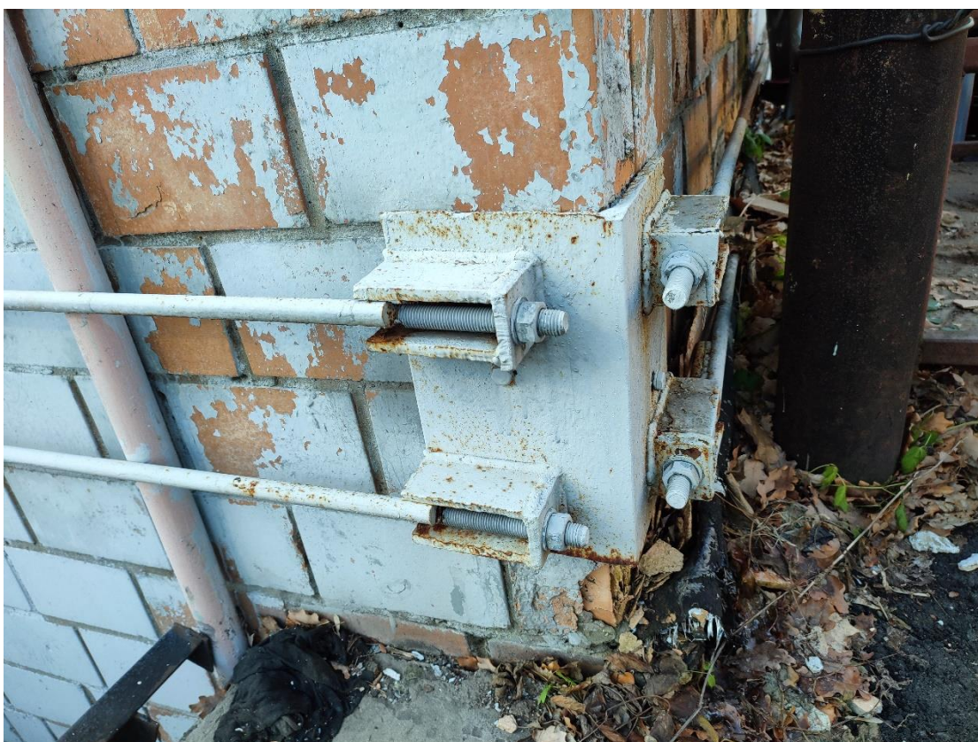
Фото 5.6. Общий вид выполненного узла усиления тяжами на углу здания
